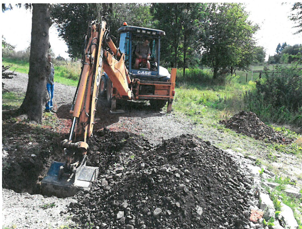
Obrázek 1 Realizace kopané sondy KS1
